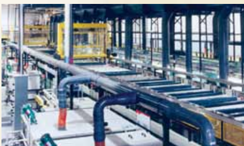
Figure 4 : La chaîne de placage multi-couche sur acier, vers 2000. Pour lui faire place, il a fallu porter à 5 500 mètres carrés (59 000 pi 2 ) la superficie de l'usine de Winnipeg.
